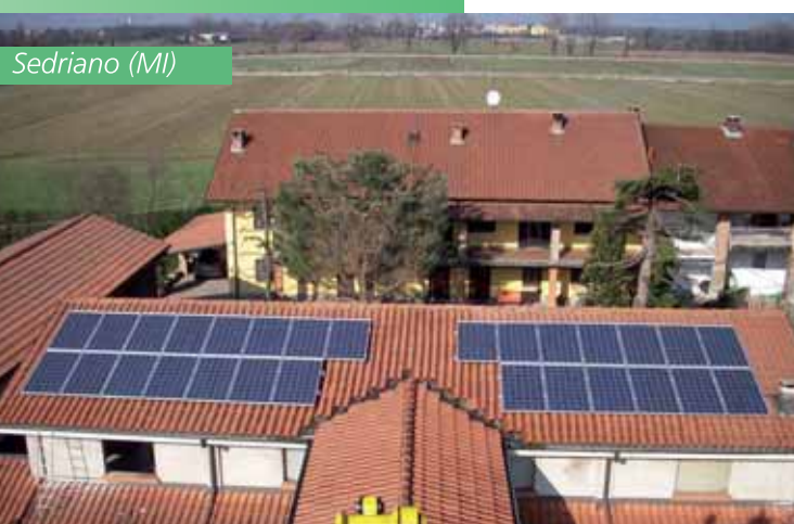
Impianto fotovoltaico da 2,94 kWp
