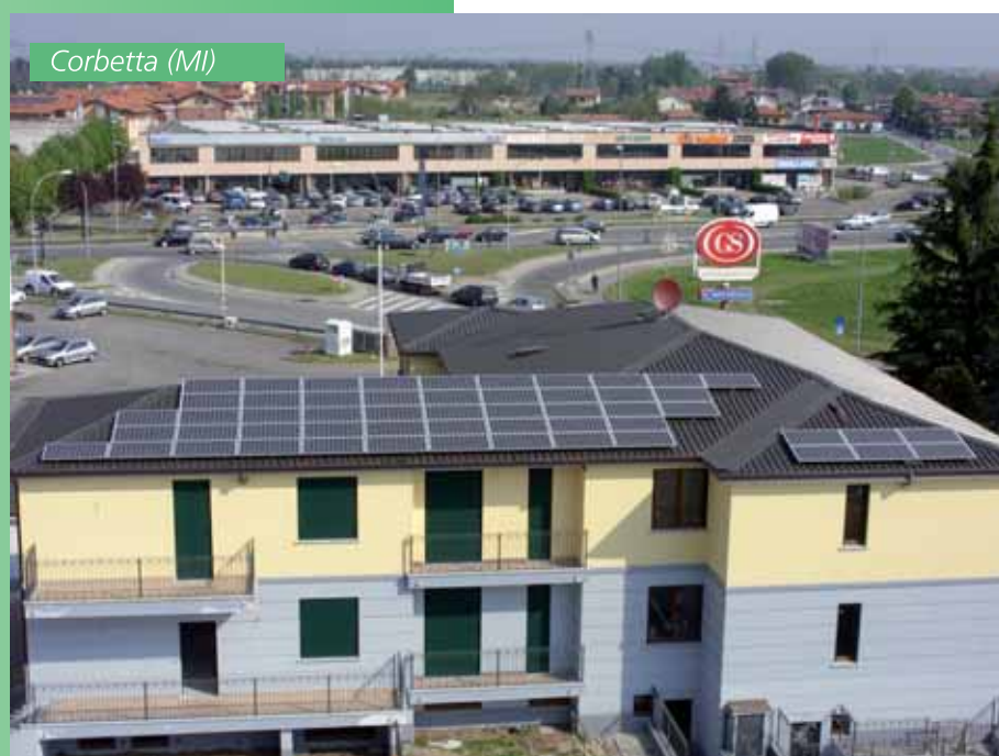
Impianto fotovoltaico da 9,72 kWp
