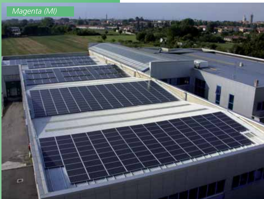
Impianto fotovoltaico da 97,92kWp
